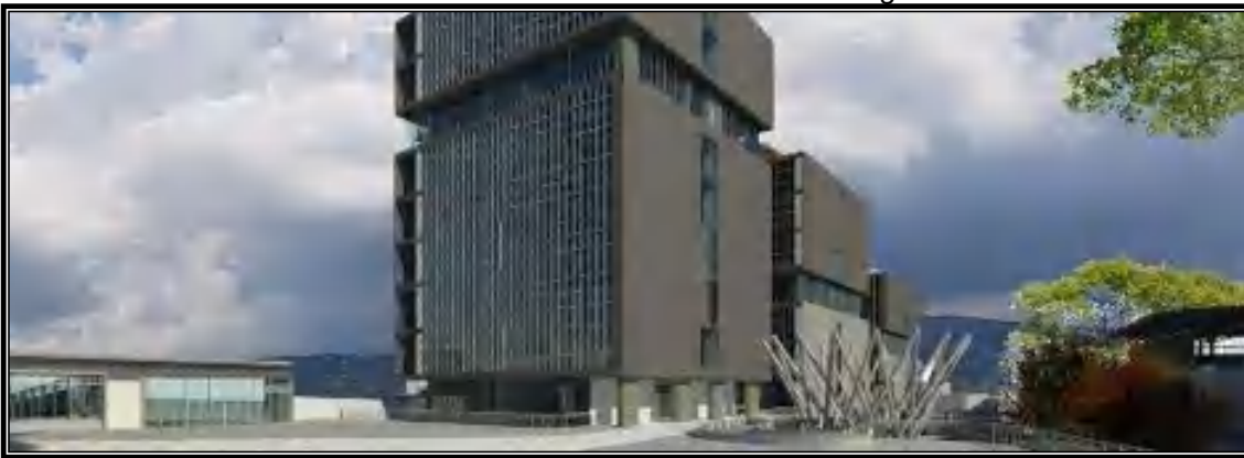
Imagen 83. Vista general del bloque 10, 12 y 13 – con la plazoleta principal Fuente: Institución Universitaria de Envigado
