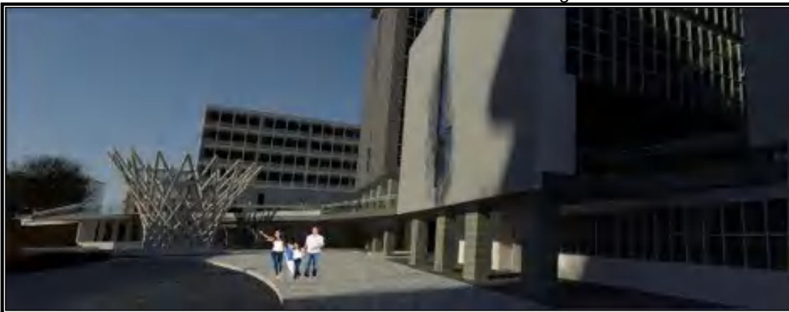
Imagen 84. Vista general del bloque 10, 12 y 13 – acceso peatonal Fuente: Institución Universitaria de Envigado
