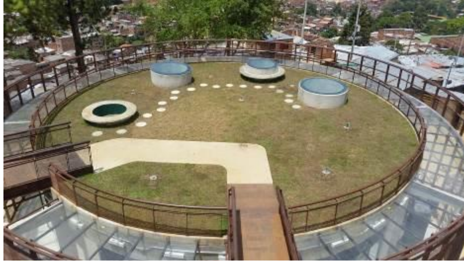
Obra Uva Santa Elena E.P.M.
