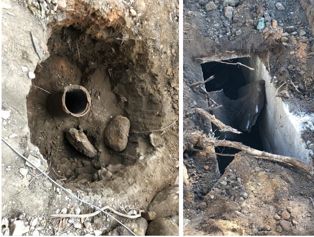
Punto de referencia en antigua fábrica. 1.960
